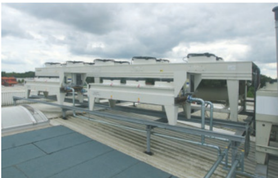
Fot. Woda do chłodzenia krążąca we wspólnym dla trzech sprężarek LENTO obiegu jest chłodzona w dwóch urządzeniach do schładzania umieszczonych na dachu hali
