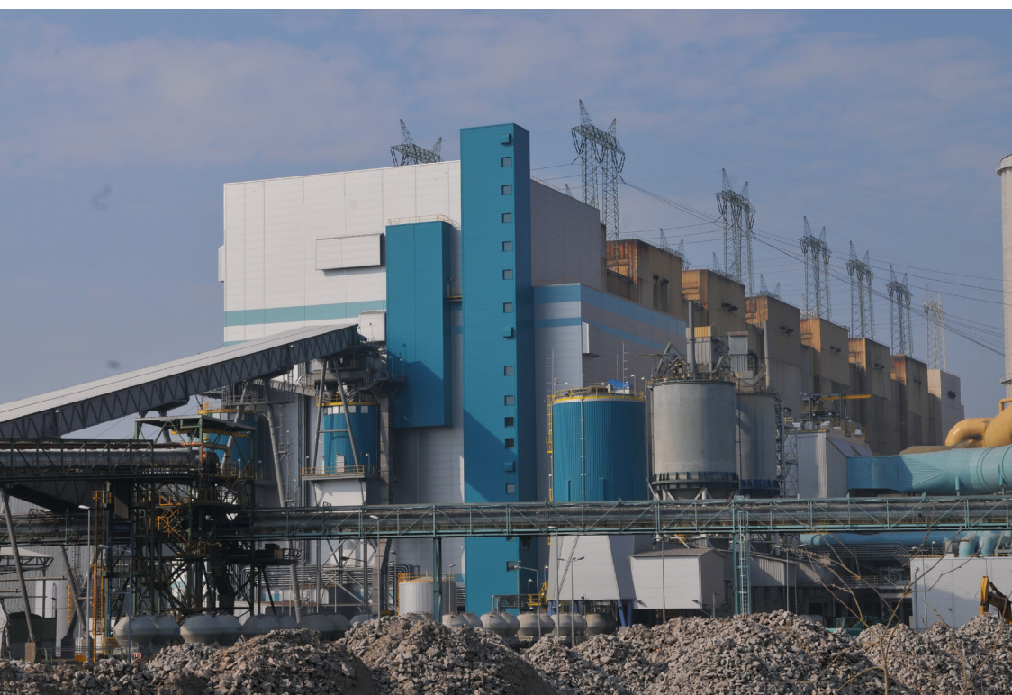
Zielony Blok w Połańcu - największy na świecie blok energetyczny opalany wyłącznie biomasą (Autor: GDF SUEZ Energia Polska S.A.).
