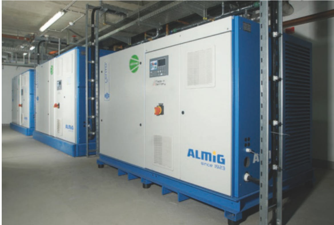
Fot. Nowa stacja sprężonego powietrza – na pierwszym planie urządzenie o mocy 31 kW, za nim dwie instalacje o mocy 110 kW każda
