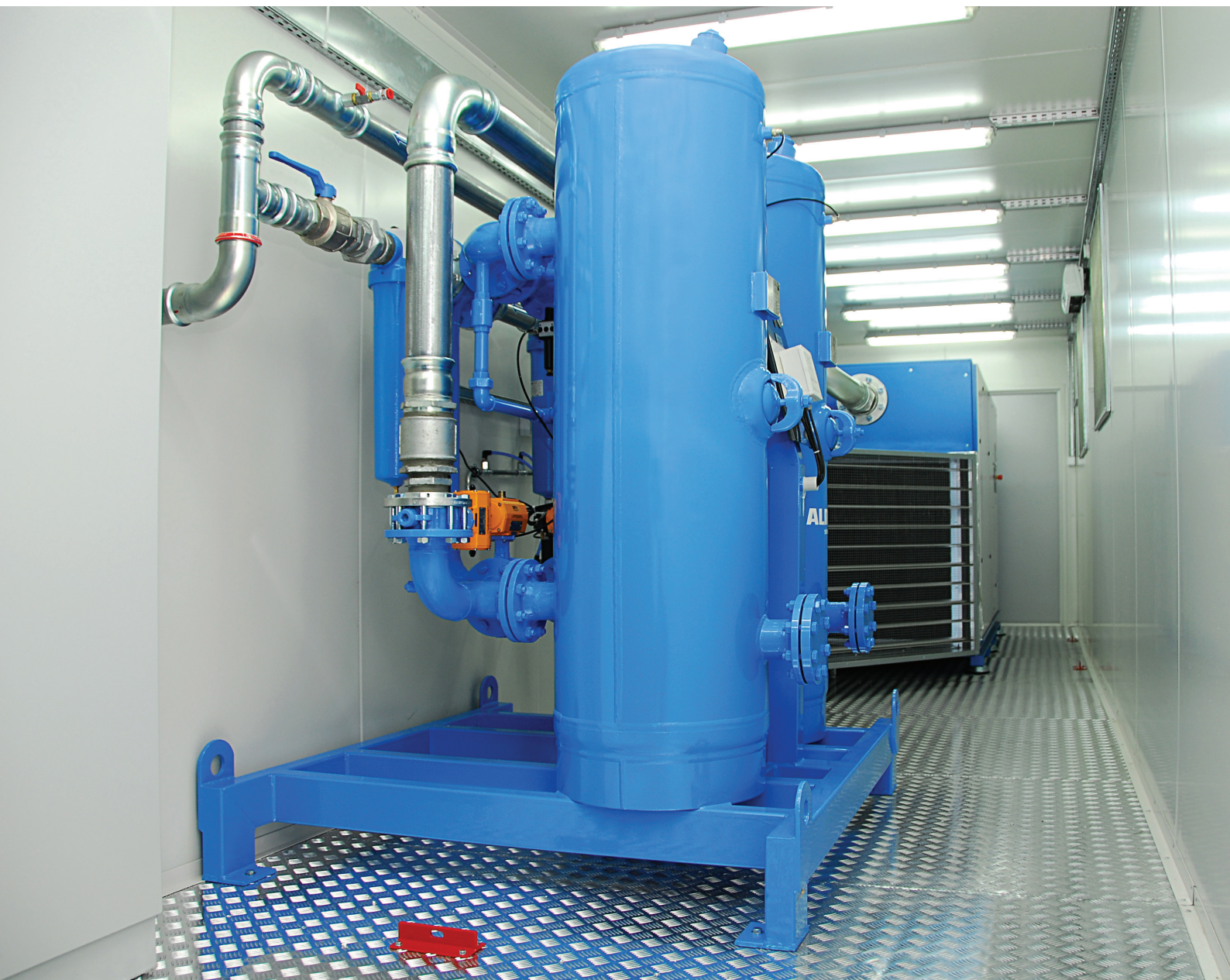
Rys. Kontenerowa stacja sprężarek ALMiG Kompressoren z osuszaczem adsorpcyjnym.
