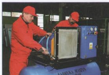
Fot. 4 Remonty agregatów sprężarkowych
