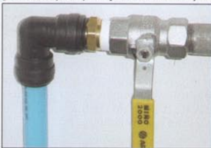
Fot. 6 Połączenie instalacji John Guest z instalacją stalową
