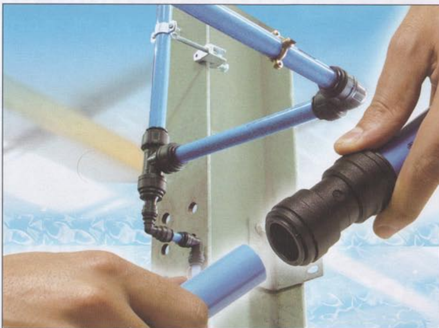
Fot. 1 Instalacja sprężonego powietrza John Guest
