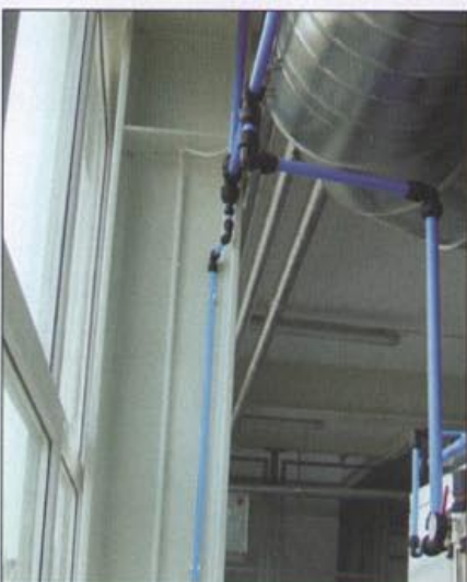
Fot. 7 Stopniowanie średnic rur w systemie John Guest
