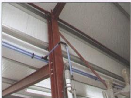
Fot. 4 Lekka konstrukcja elementów John Guest ułatwia montaż instalacji na wysokościach
