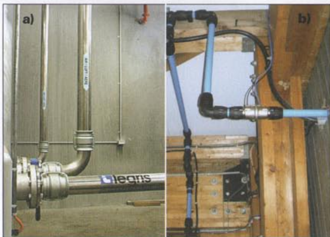
Fot. 4 a) Transair w rurach ze stali nierdzewnej \phi 100 mm, b) zdalnie sterowany zawór odcinający powietrze
