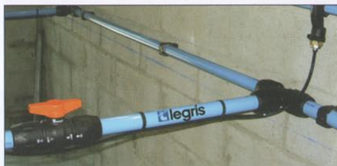
Fot. 2 Transair jest odporny na oleje sprężarki
