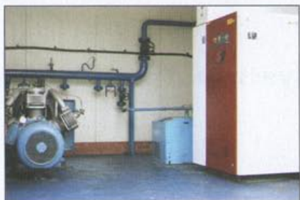
Fot. 2 Przeskok z epoki sprężarek tłokowych do łopatkowych. Sprężarka WITTIG ROL 50 (30 kW) zasilająca Zakłady Metalowe POSTĘP SA w filii w Gliwicach
