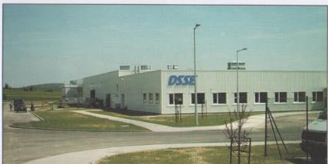
Fot. 3 Jeden z obiektów wyposażonych w sprężarki Ingersoll-Rand (DSSE, Żarów)
