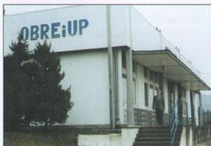
Fot. 1 Budynek OBREiUP w Kielcach
