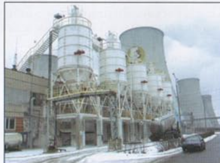
Fot. 1 Silosy na materiały sypkie z zamontowanymi pulsatorami pneumatycznymi
