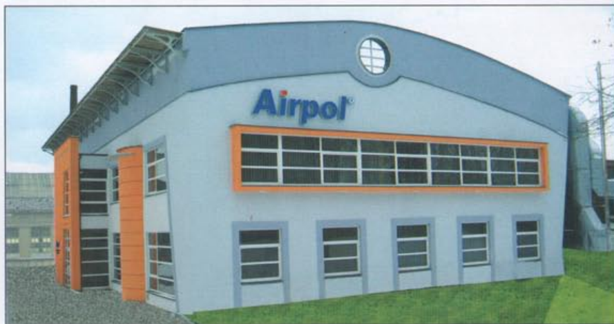
Fot. 1 Nowa siedziba firmy
