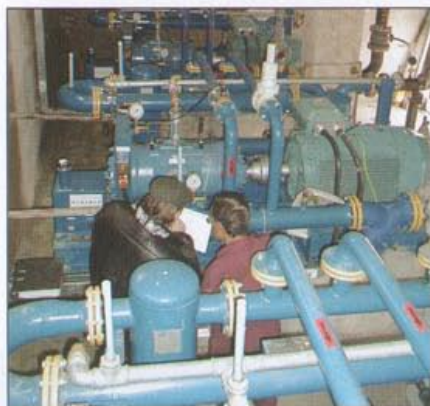
Fot. 4 Sprężarki po zamontowaniu...
