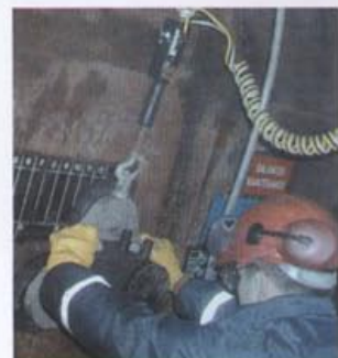
Fot. 3 Mocowanie podciśnieniowe typu VAC
