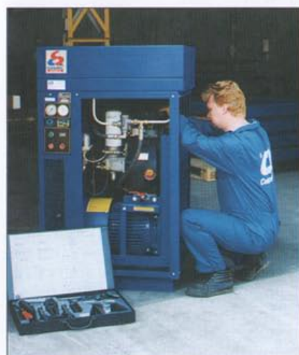
Fot. 8 Pracownik podczas przeglądu sprężarki CRS 22
