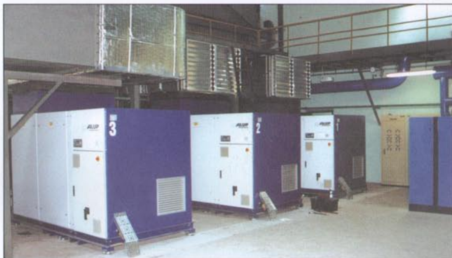
Fot. 1 Zespół sprężarek śrubowych ALUP SCG o łącznej mocy 1280 kW w Hucie Zawiercie
