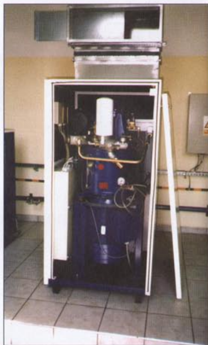
Fot. 2 Zbliżenie sprężarki WITTIG ROL 50 topline od strony obsługowej. Widoczne rozmieszczenie podzespołów oraz szczegóły systemu odzysku gorącego powietrza zrzutowego.
