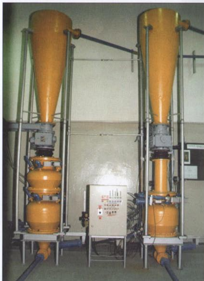
Fot. 1 Instalacja pomiarowo-badawcza transportu pneumatycznego
