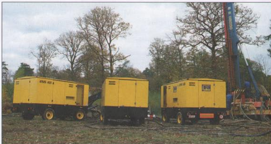
Fot. 1 Sprężarki przemieszczalne na 25 bar z silnikiem spalinowym Mercedesa przy pracach wiertniczych
