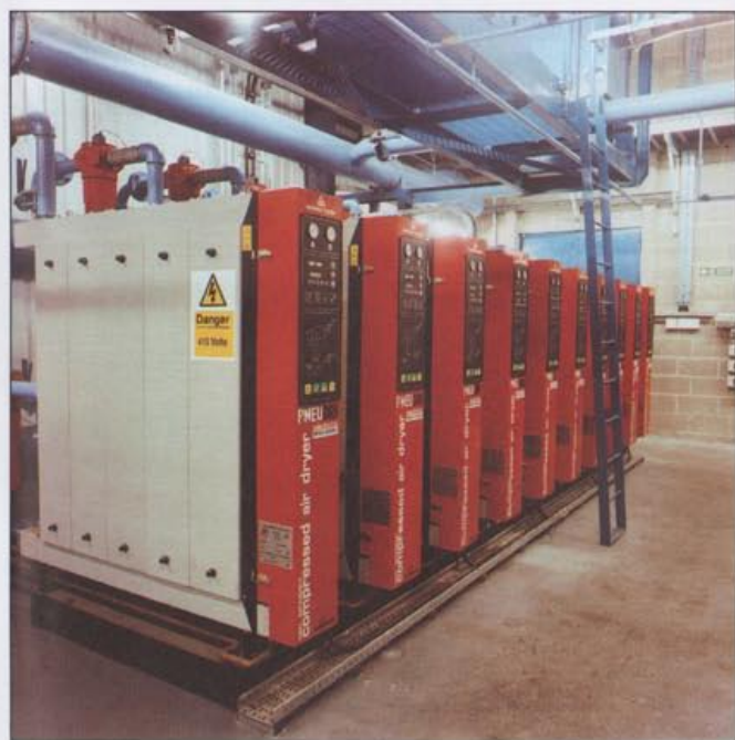
Instalacja składająca się z 10 modułów PNEUDRI Maxi ze sterowaniem elektronicznym
