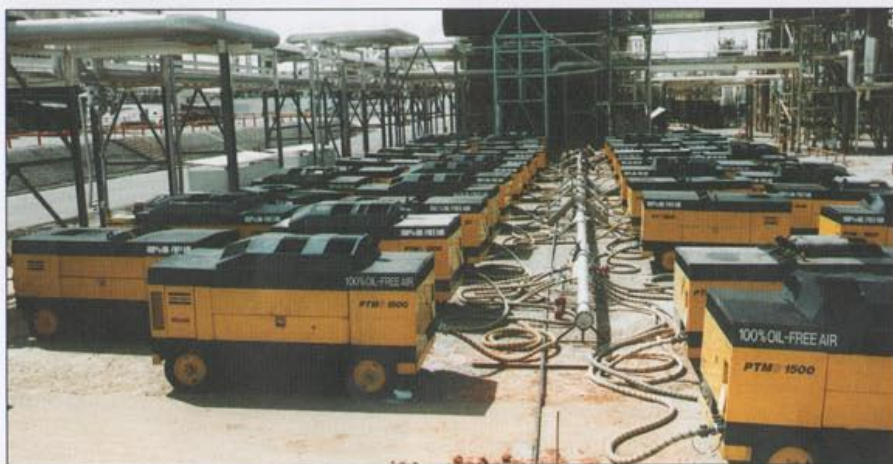
Fot. 2 Wynajęte sprężarki zastępują remontowaną sprężarkownię w rafinerii naftowej
