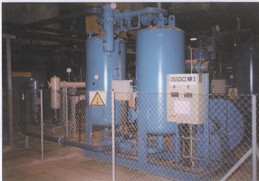
Fot. 2 Osuszacz adsorpcyjny ultrafiltr HRE 3500 z układem sterowania „ultraclean” wyposażony w filtr wstępny i końcowy
