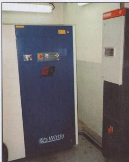
Fot. 2 Sprężarka zmiennoodrotowa WITTIG ROL 85 topline FU z przemiennikiem częstotliwości PDL Electronics
