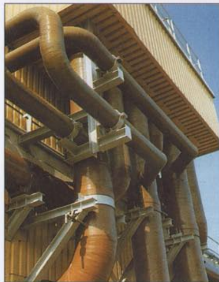
Fot.1 Kompozytowe przewody ciśnieniowe do mediów agresywnych
