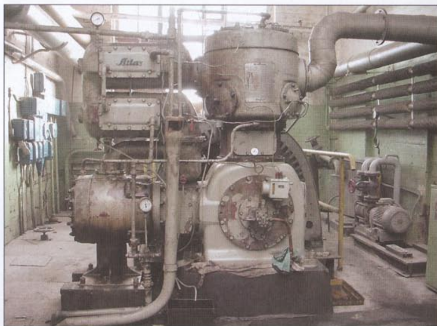
Fot. 1 Wyłużona sprężarka tłokowa Atlas Diesel sprzed 50 lat
