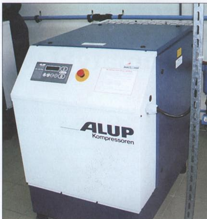
Fot.3 Sprężarka ALUP serii SCK o mocy 37 kW
