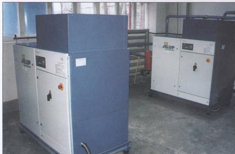
Fot. 4 Grupa sprężarek ALUP serii SCK o mocach 55 kW
