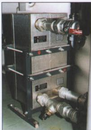
Fot. 2 Wymiennik ciepła typu PTG
