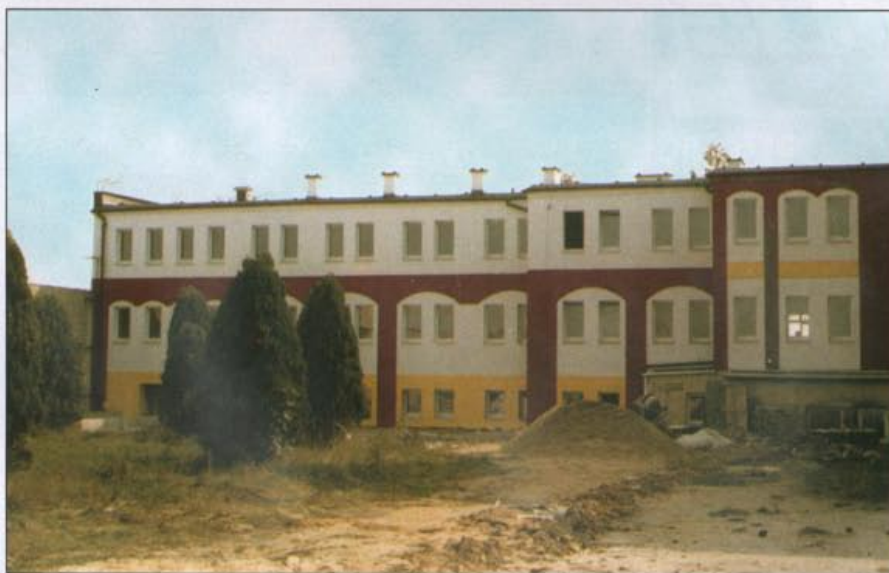
Fot. 2 Nowa siedziba firmy VECTOR w budowie
