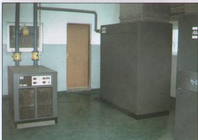
Fot. 2. Sprężarkownia po modernizacji
