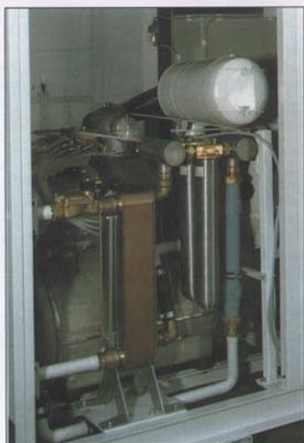
Fot. 1 Sprężarka typu CWF-chłodzona wodą
