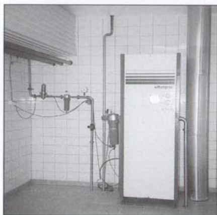
Rys. 2 Sterylizacja sprężonego powietrza dla drożdźowni
