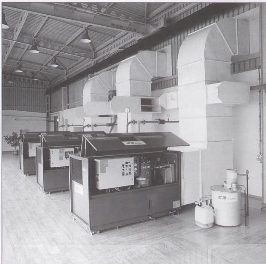
Polifarb Cieszyn - stacja sprężarek
